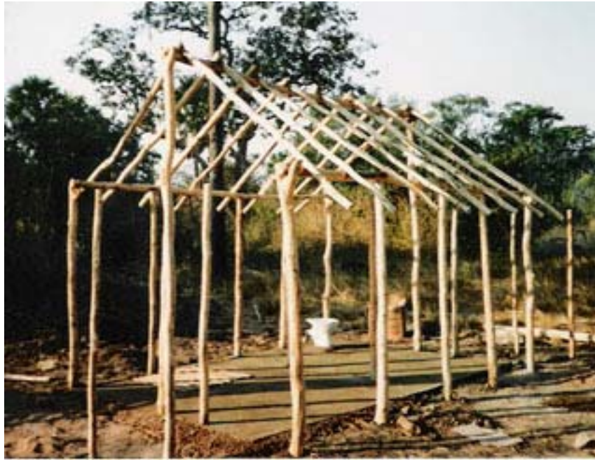
Raise frame, pour cement floor, set the toilet
